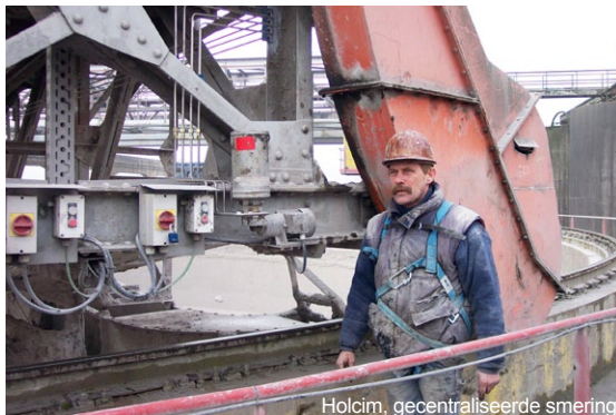
Holcim, gecentraliseerde smering
