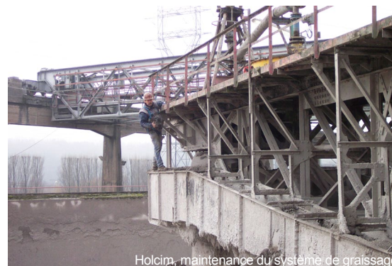
Holcim, maintenance du système de graissage
