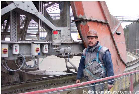
Holcim, graissage centralisé
